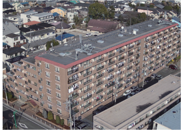
※ドローンにて上空から撮影 本モデル事業を活用し外壁タイル調査に利用
