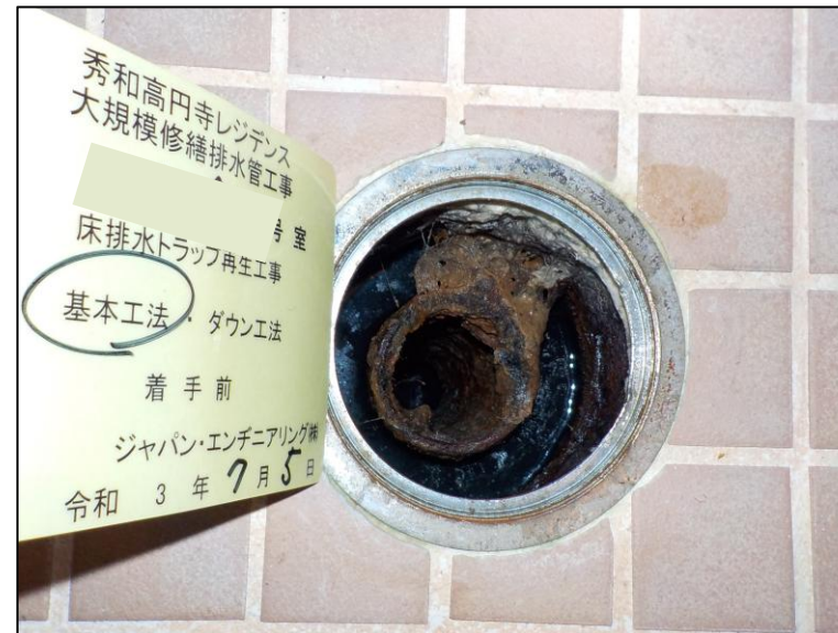
床排水トラップ 施工前
