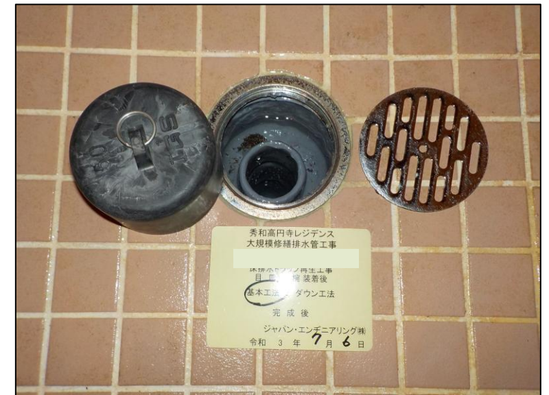
床排水トラップ 施工後
