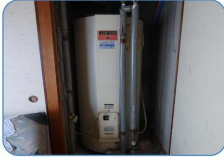
電気温水器とガス給湯器が混在していた給湯方法を、ガス給湯に統一。
