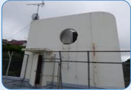
高架水槽方式から、直結増圧方式へ変更。
