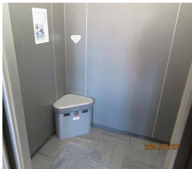
防災キャビネット設置状況
