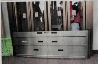
マンション内部への浸水を防ぐ「止水板」＝昨年11月
