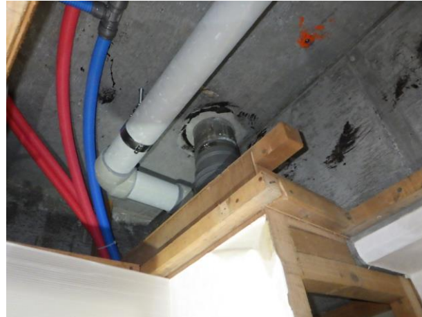
在来浴室のみスラブ下配管 樹脂管更新
