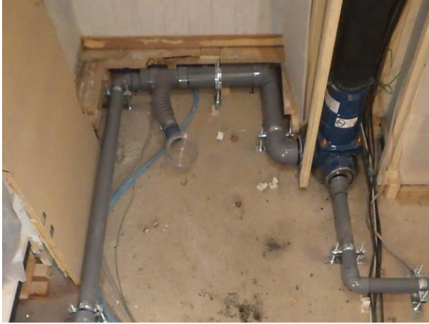
洗面室排水管更新
