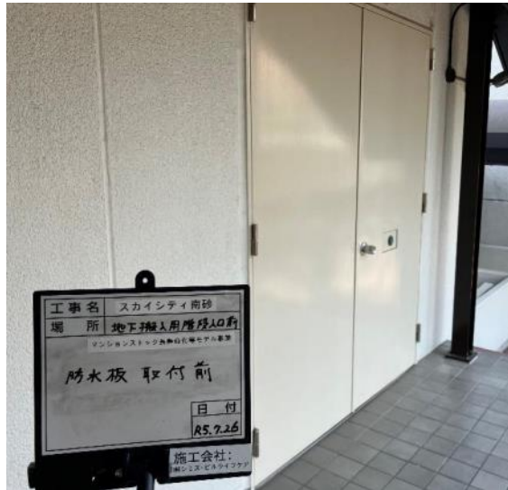
防水版設置前
