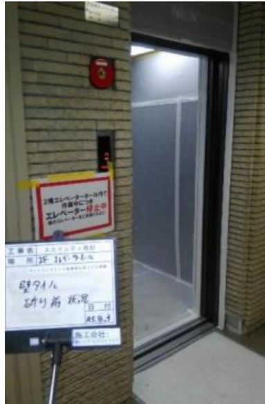
防水版設置前
