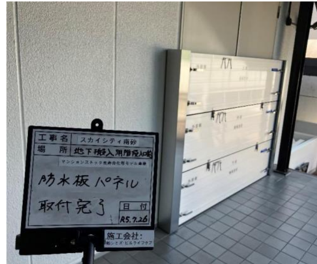
防水版設置後
