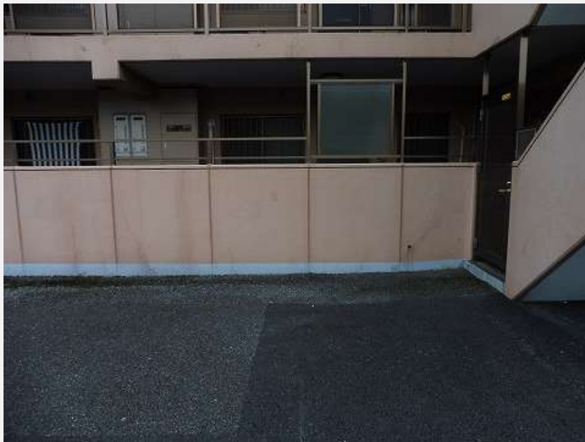
(2)屋外階段出入口改修前
