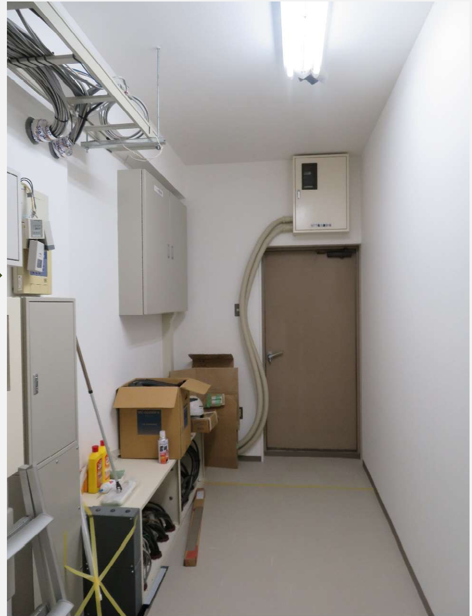
防災倉庫改修後
