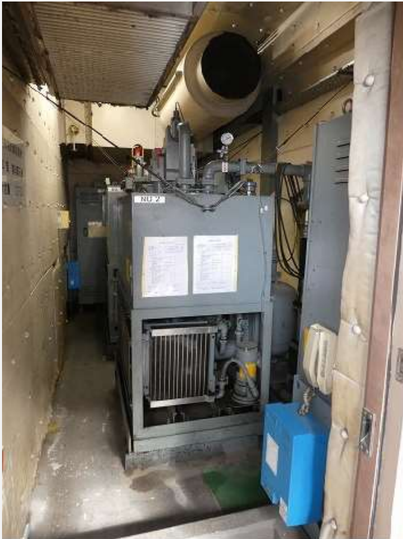
エレベーター機械室(改修前)
