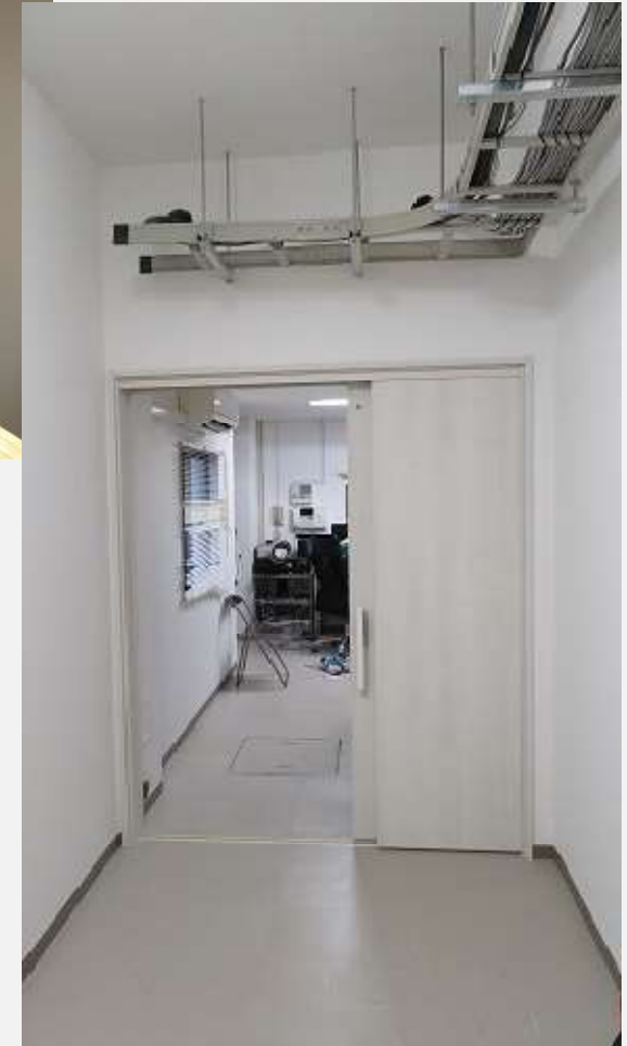
新規扉（倉庫側）
