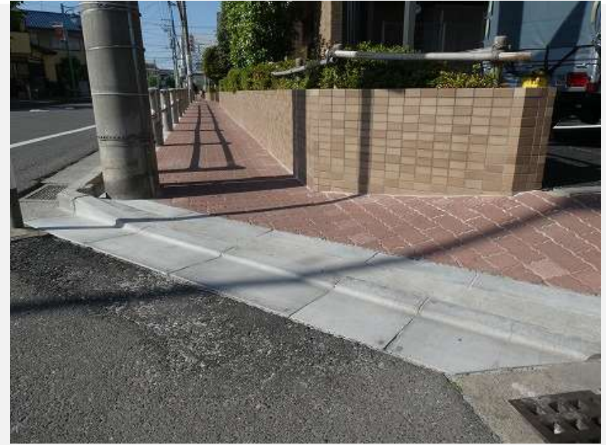
(1)自主管理歩道スロープ化改修後
