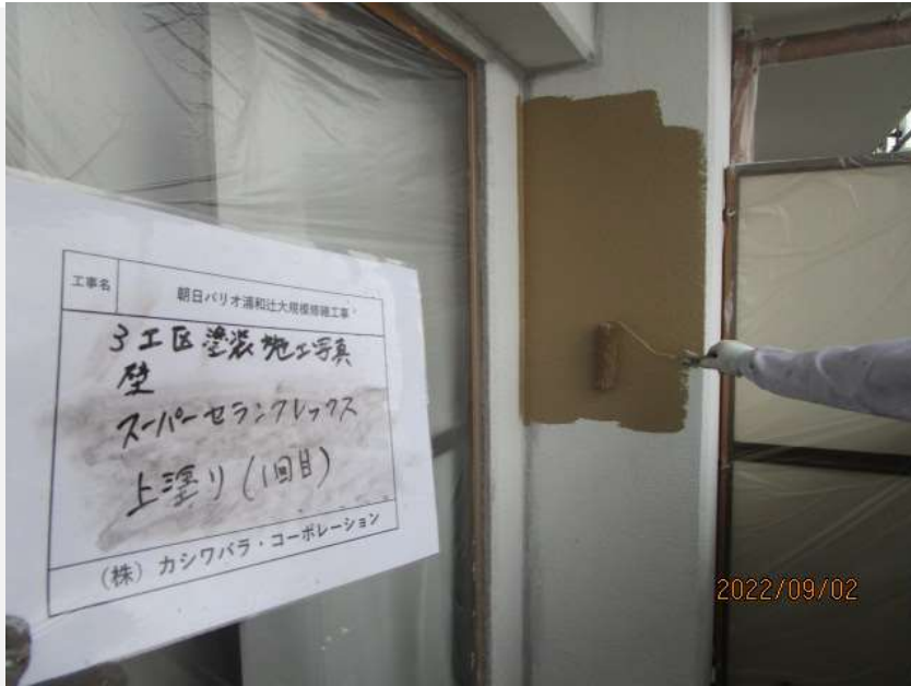
高耐久外壁塗装材の採用
