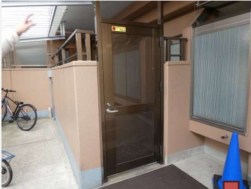
駐輪場側アルミ門扉改修前
