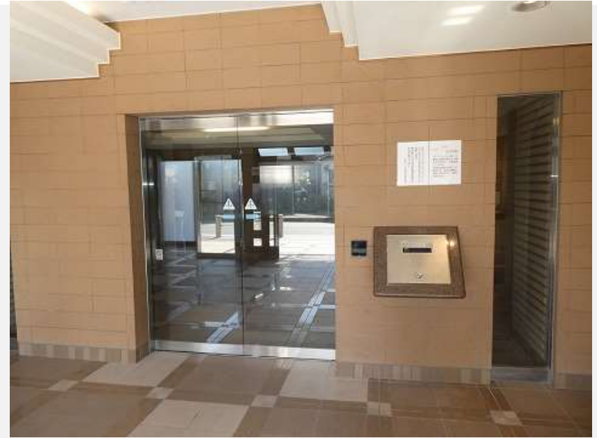
エントランスロビー部ハンズフリー改修後
