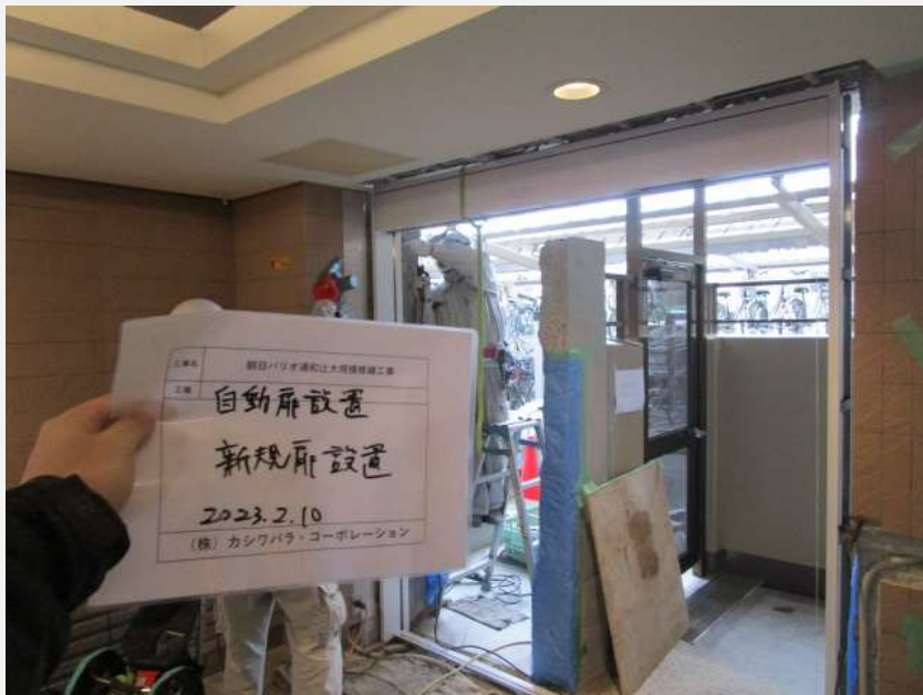
(3)新規自動ドア枠設置
