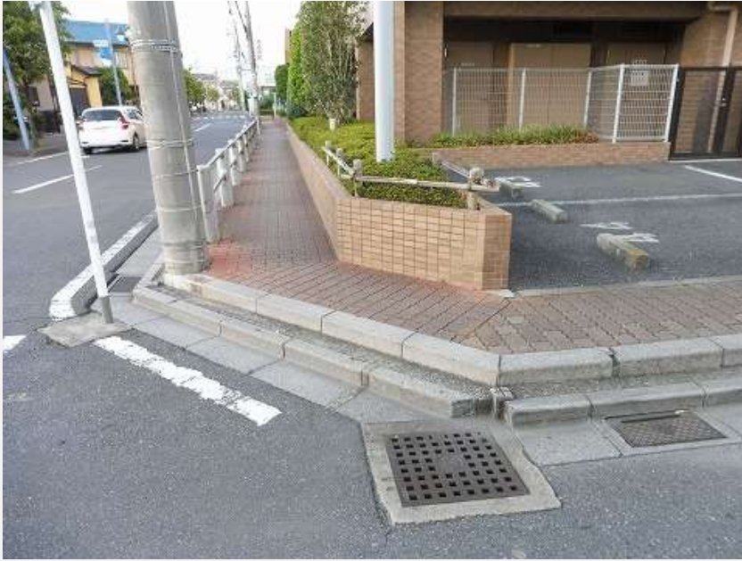
(1)自主管理歩道改修前
