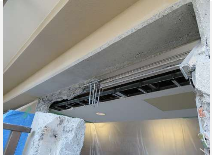
(3)既設扉及び周囲壁解体撤去
