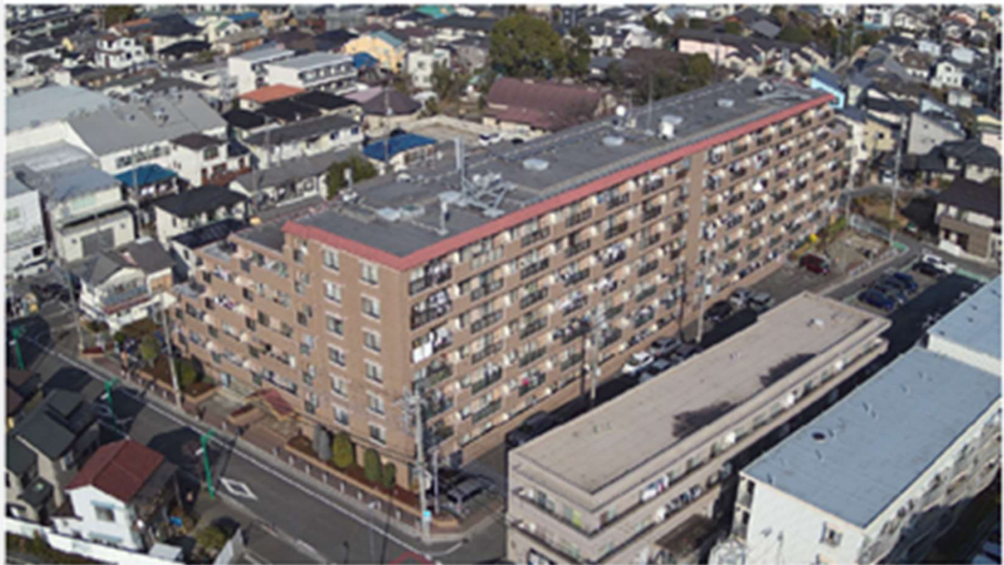
工事前にドローンで撮影した建物全景
