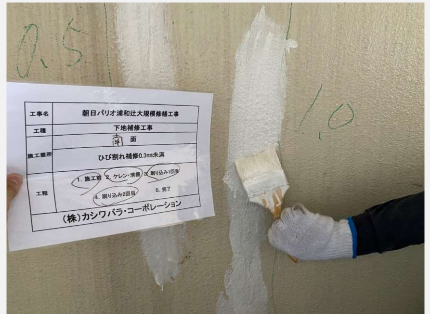
弾性塗膜防水材料によるひび割れ補修 6
