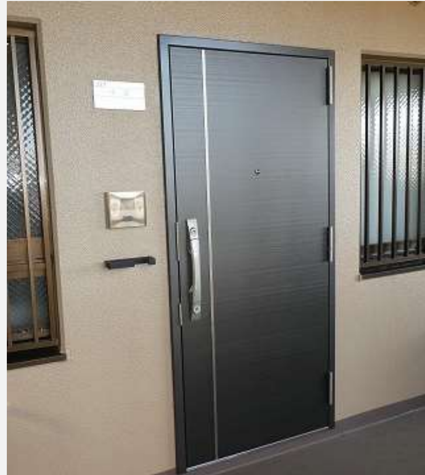
(5)玄関ドア改修後
