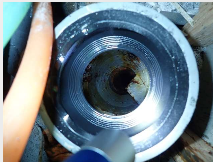
1013号室浴室・洗面・洗濯系統集合管継手 洗浄後継手内部目視調査
