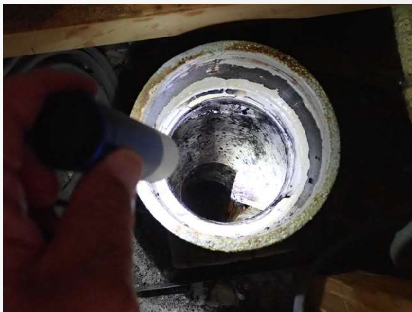
217号室台所系統集合管継手 洗浄後継手内部目視調査
