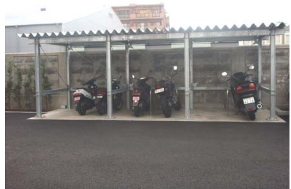
転倒防止柵を付けたバイク置場
