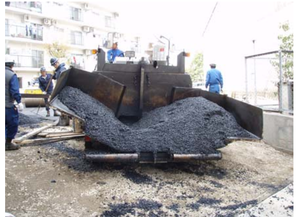
アスファルト舗装の作業風景
