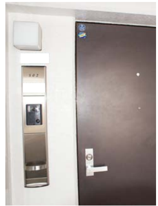
玄関脇に新設された複合パネル
