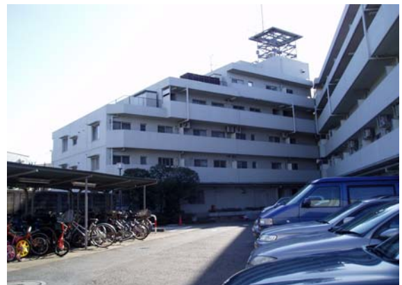
北側から見た建物外観 高架水槽架台は撤去した
