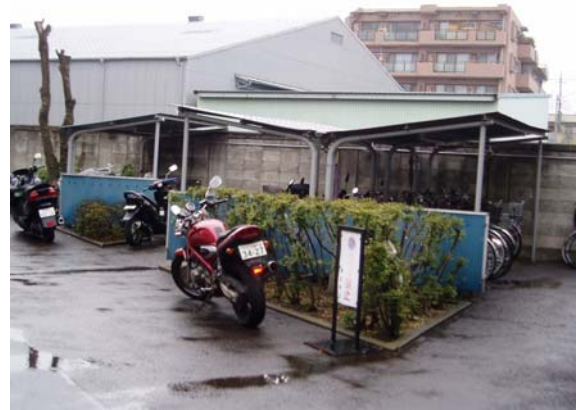
改修前の駐輪場、バイク置場
