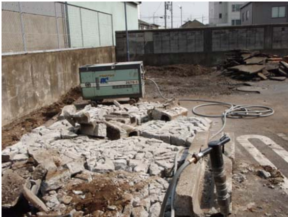
既存舗装路盤の解体作業風景
