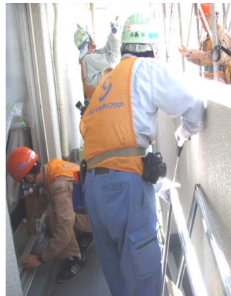
アルミサッシ分解清掃作業風景
