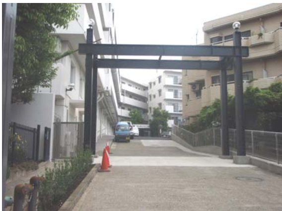
マンション正面に新設された藤棚の門柱ゲート
