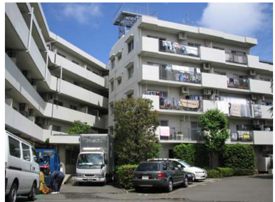
南側から見た建物外観 (改修前)
