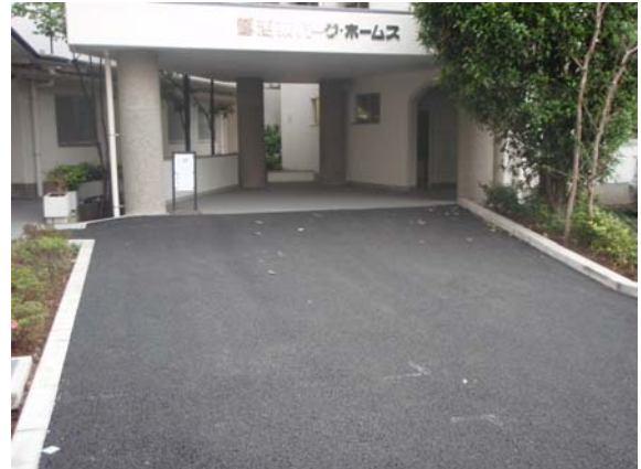
段差が解消されたエントランス廻り（改修後）
