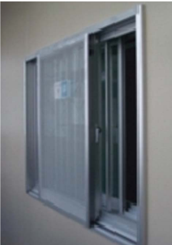
▲改修後(サッシの二重化)
