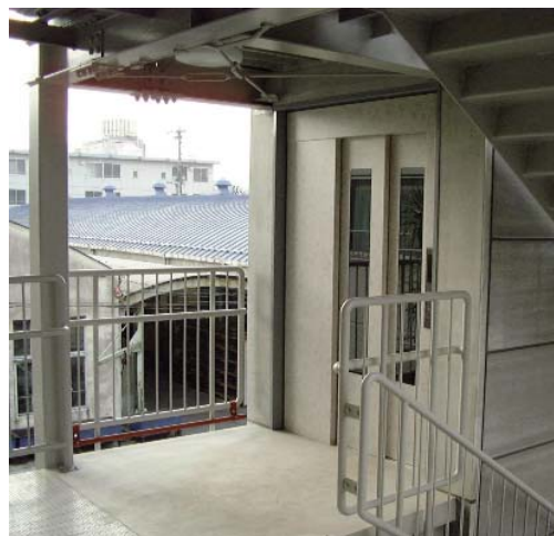
▲改修後(増設されたエレベーター)
