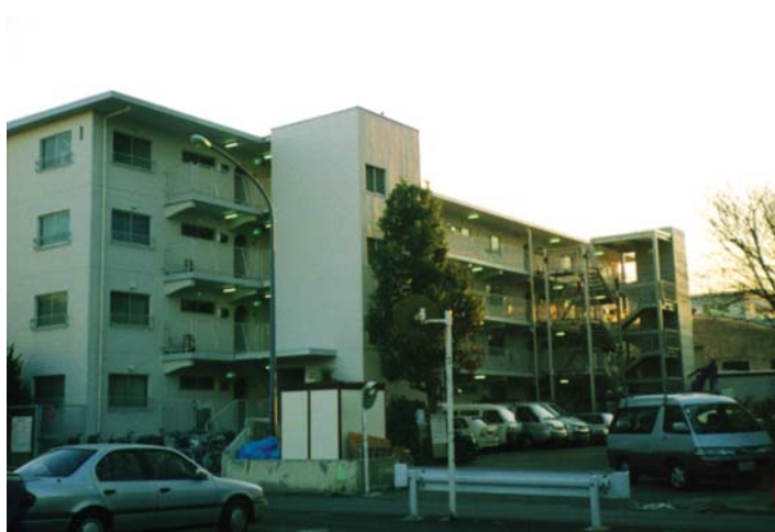
▲改修後(写真右奥に増設されたエレベーター)
