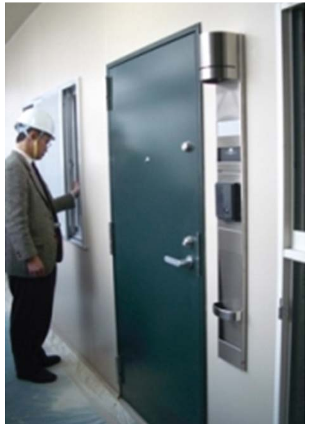
▲改修後(玄関扉の更新)
