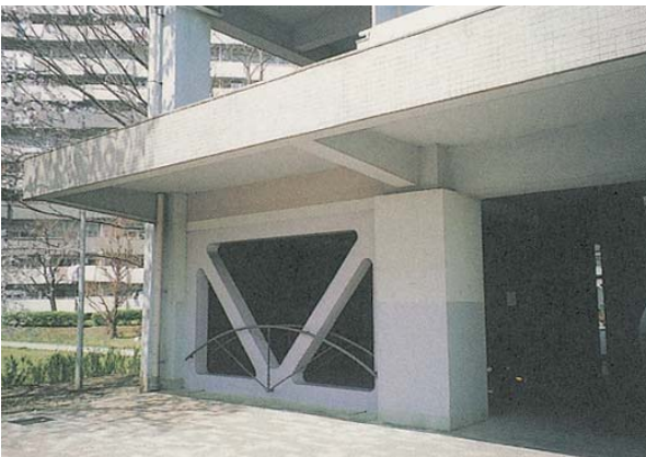
ピロティ部分の鉄骨ブレースによる耐震補強
