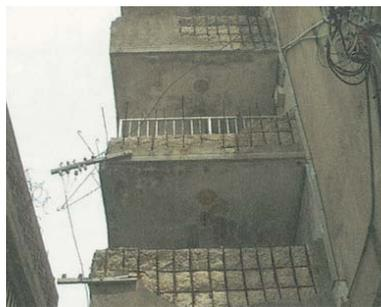
バルコニー部分のコンクリート内の鉄筋が錆び、それを覆うコンクリートが剥離している
